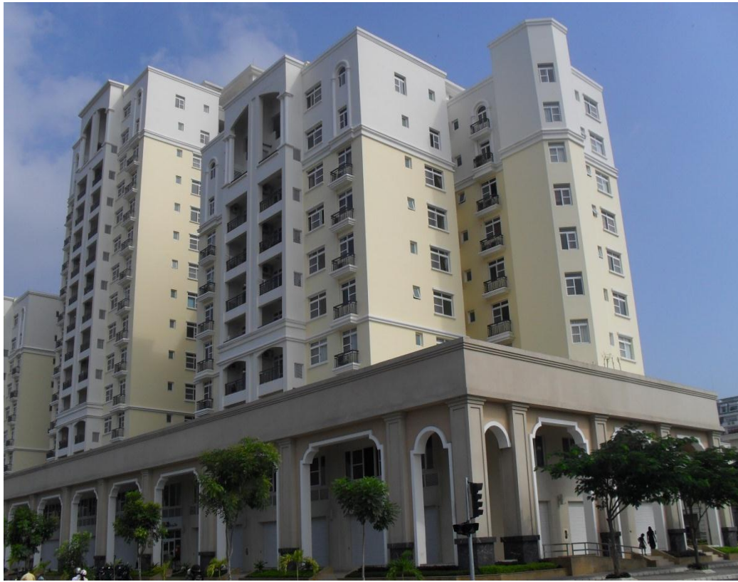
Cung cấp nhân công lắp đặt nhôm kính Công trình: Chung cư H 29 Phú Mỹ Hưng
